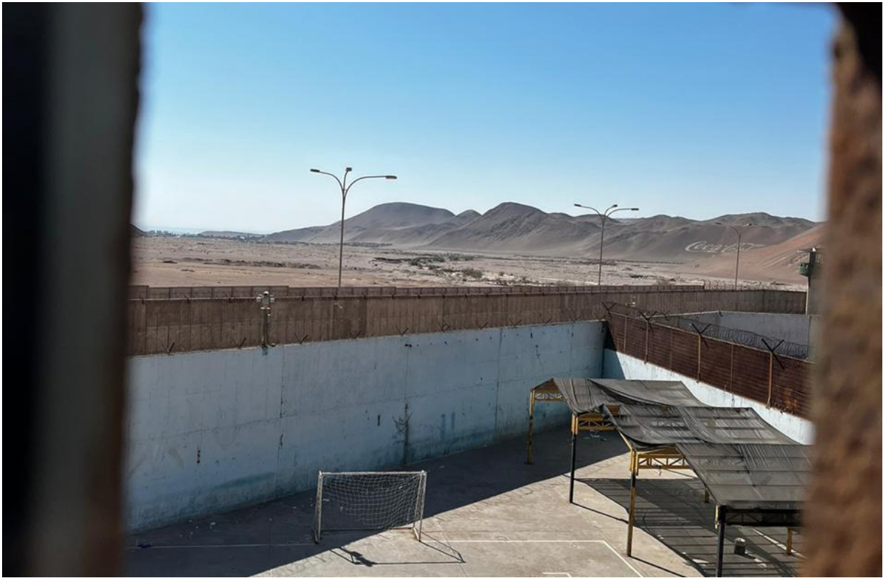
Vista desde el interior de Complejo Penitenciario de Arica. Fotografía CPT.
