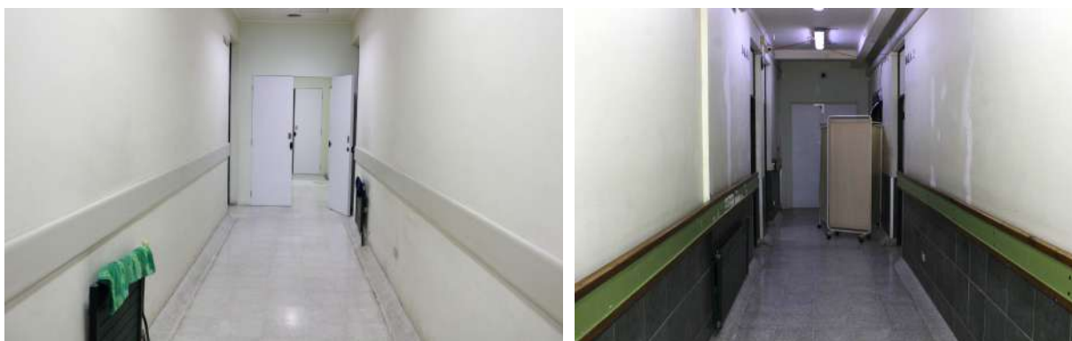
Fotografía N° 3 y N° 4 : Pasillo segundo piso y pasillo primer piso
