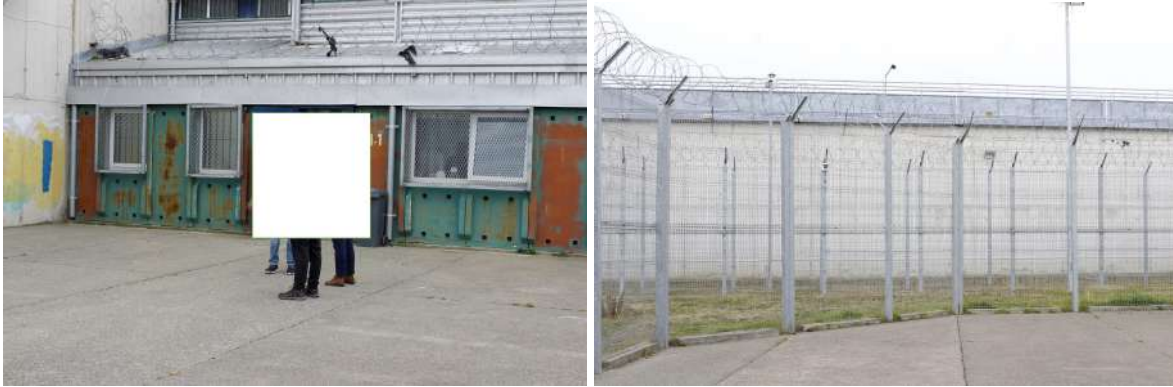
Fotografía N° 4 y 5: Patio exterior de la unidad
