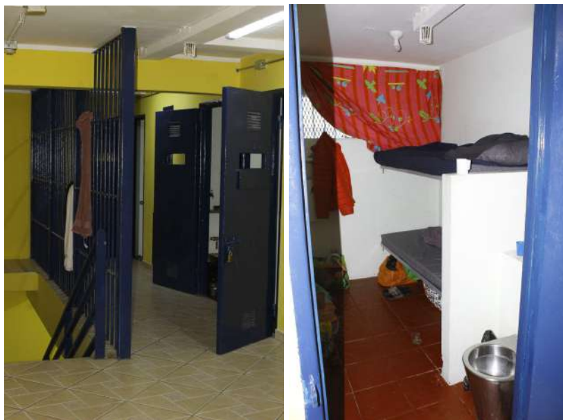
Fotografía N° 1 y N° 2: pasillo segundo piso y celda
