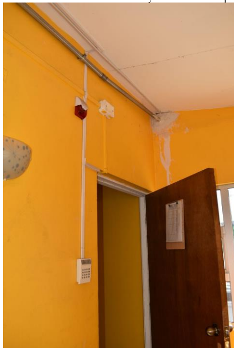
Foto N°6: Alarma fuera de las habitaciones y baños de las personas mayores.
