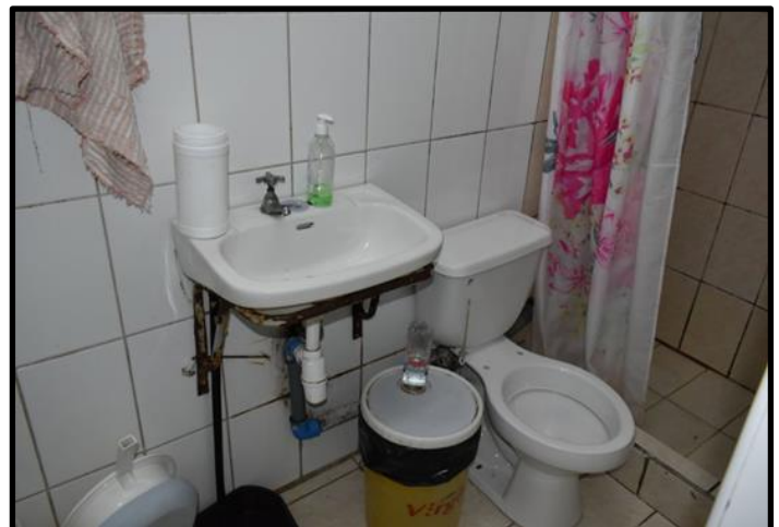
Fotografía 5. Inodoro y lavamanos de Sección Femenina.
