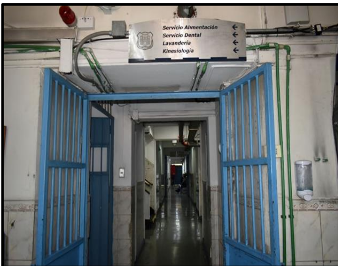
Fotografía 1. Pasillo primer piso Hospital Penitenciario
