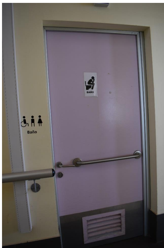
Foto N°4: Puerta de ingreso de un baño.
