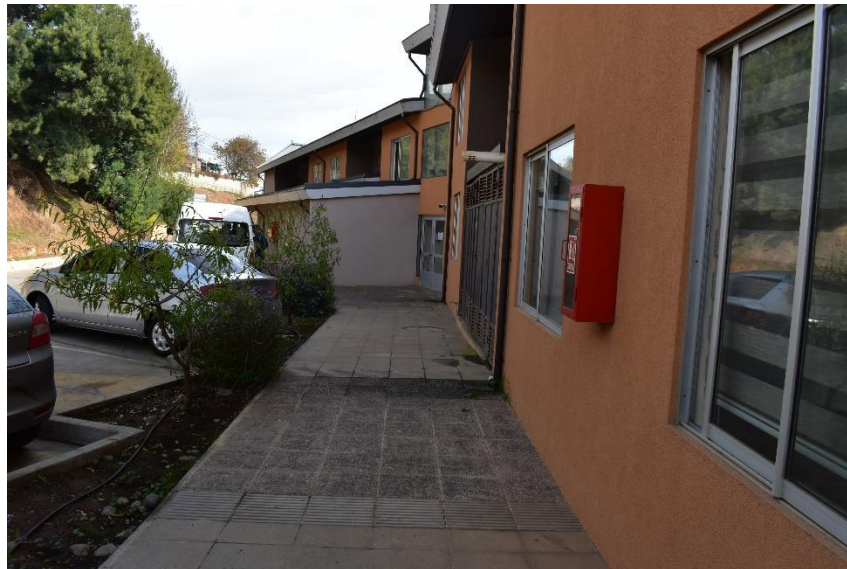
Foto N°7: Zona de seguridad (estacionamiento).
