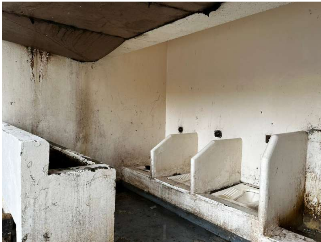
Baños. Módulo de población penal.
