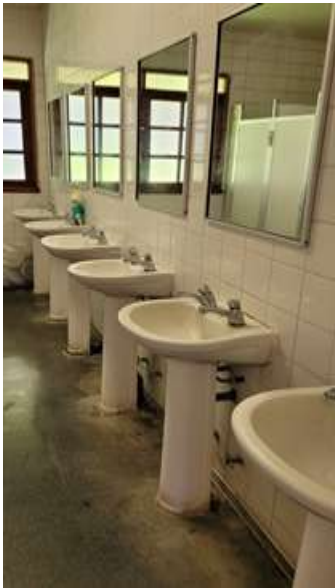
Renovación de baños
