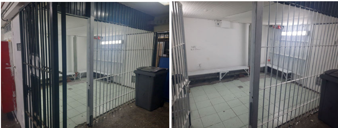
Fotografías 1 y 2. Celda de contención C.P.F. de San Miguel, tomada el día 13 de enero de 2023 por el equipo del CPI.
