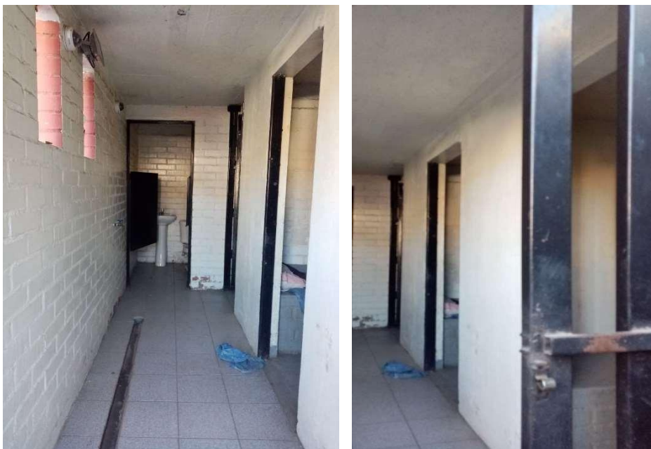
Fotografía N° 7(pasillo ingreso a las celdas)
